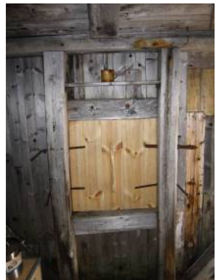
På grund af bjørnenes besøg besluttede vi at producere skodder til vinduerne for at bjørnesikre hytten bedre. Skodderne har vi sat på indvendig side af vinduerne for bedst at bevare det oprindelige udvendige udtryk.
