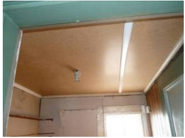
T.v. I flere af rummene i Ørnereden havde bjørnen ødelagt loftspladerne i 2013. T.h. Nye loftsplader er blevet monteret og klar til bemaling.
