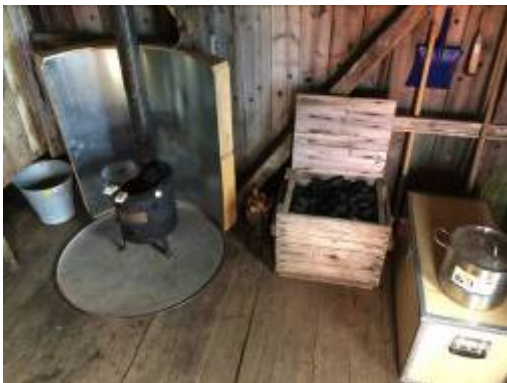
Den runde form på dækningspladen nødvendiggjorde så også en rund reflektorskærm, hvilket blev produceret af materialer som Nanok-ovnen var indpakket i.
